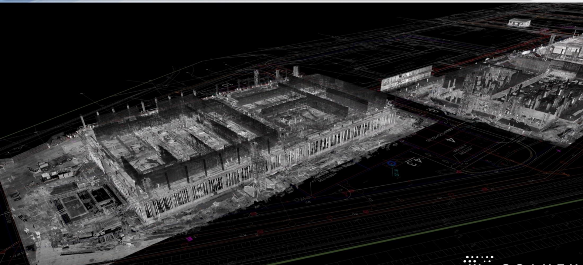
Udokumentowane w 3D kroki milowe realizacji
